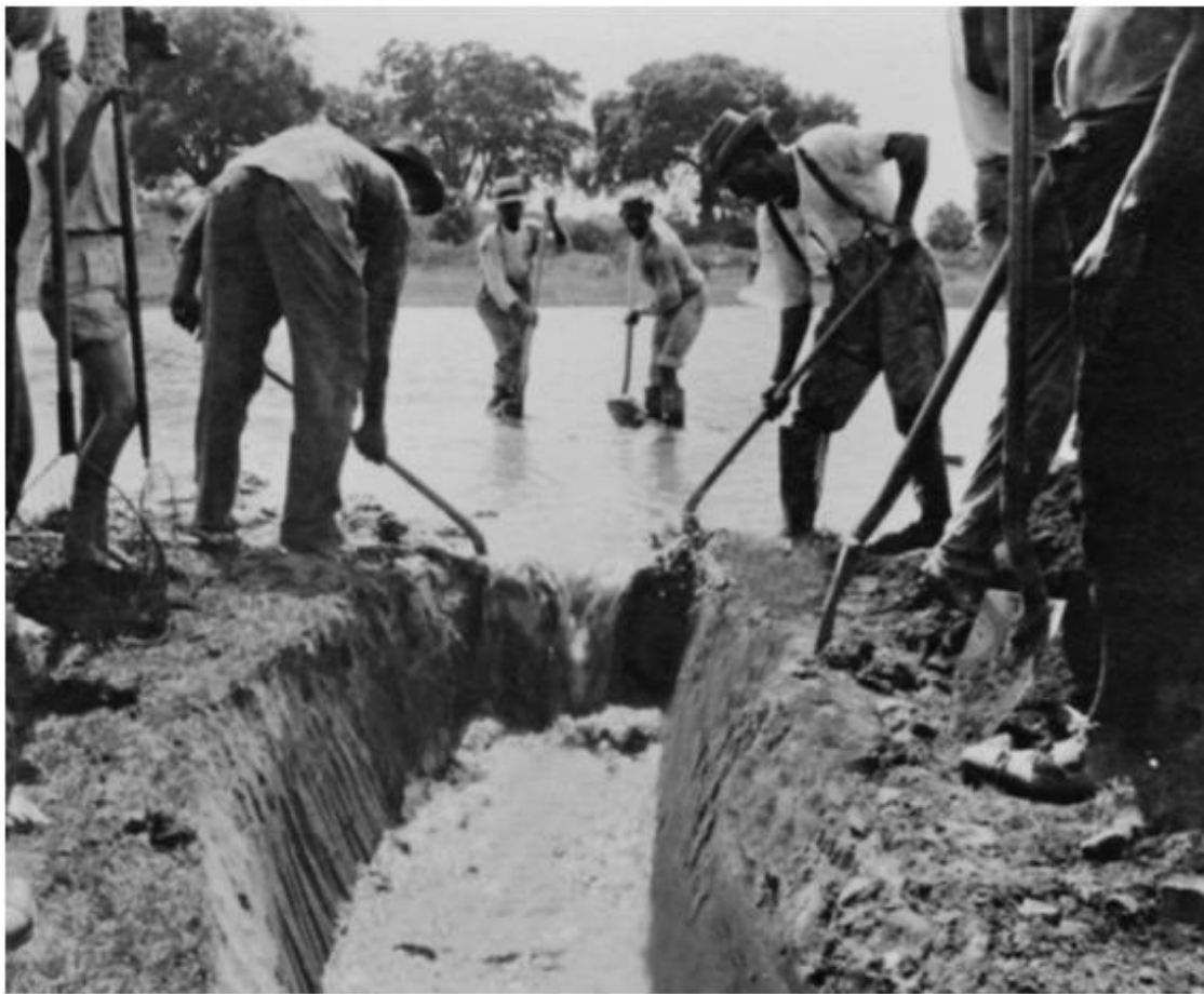
图6. 3 20世纪20年代的一张照片展现了一幅美国南部地区工人们挖排水沟渠以促进控制蚊子的画面。杜绝死水以减少那些传
