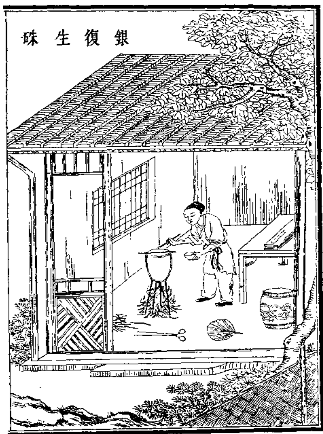
图 3-1 升炼朱砂 (采自喜咏轩版《天工开物》)
